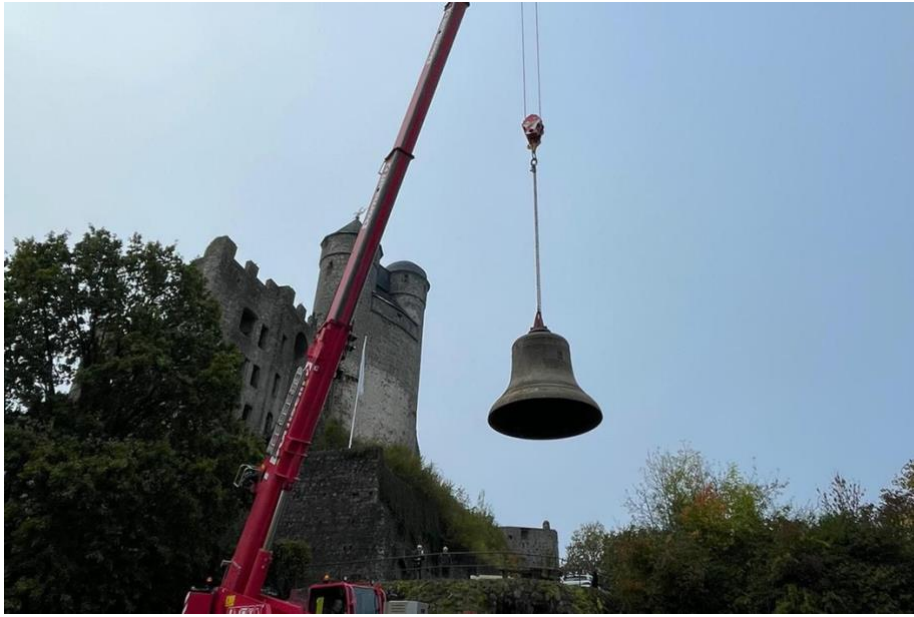
Burg Greifenstein: 2,6-Tonnen-Glocke schwebt per Kran heran Ein Kran hebt die Glocke auf ihren neuen Platz.
